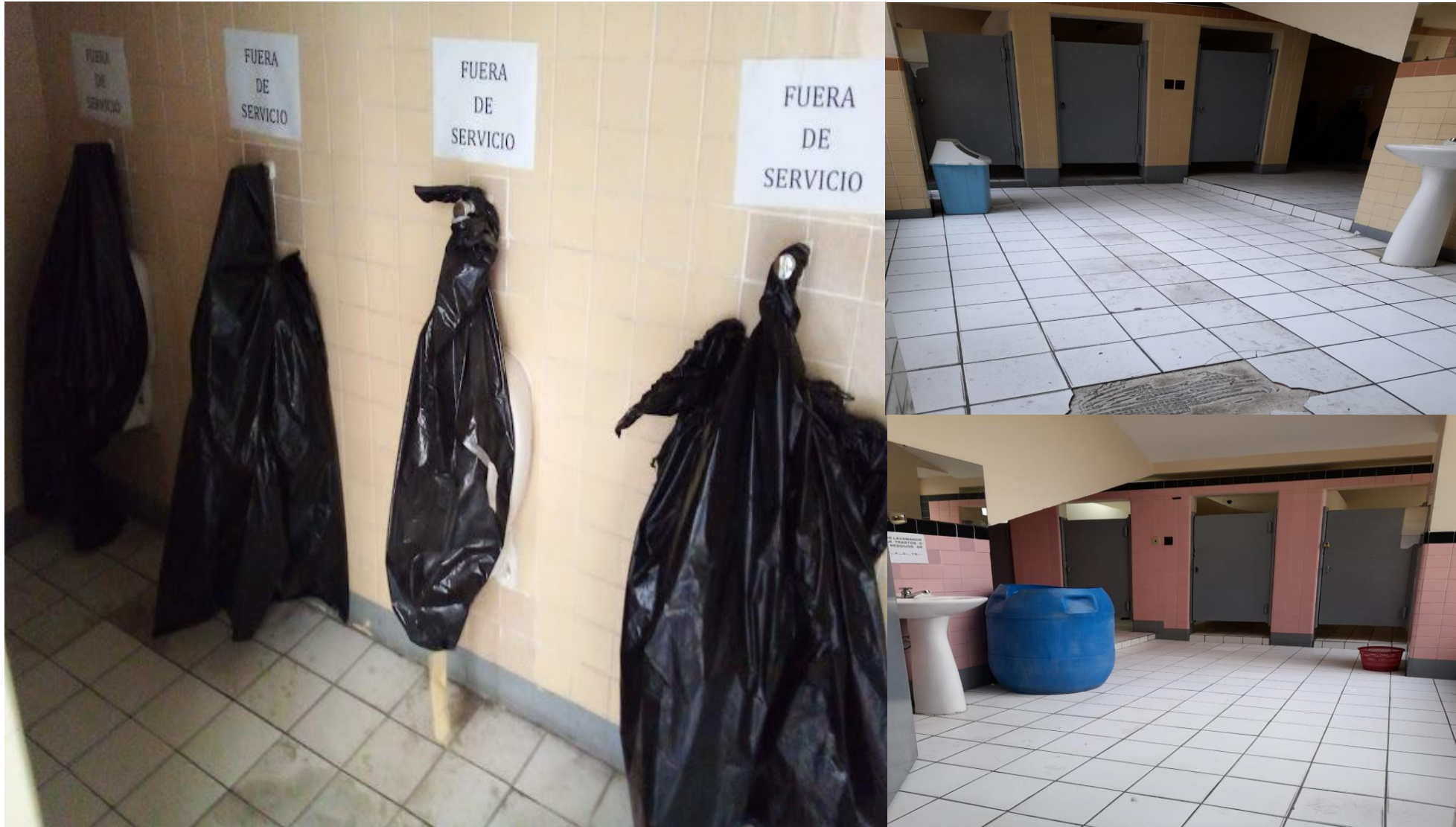
Imagen 25. Antes: Sanitarios del Edificio de Biblioteca Nacional (Fotos: M9 CUDE).
